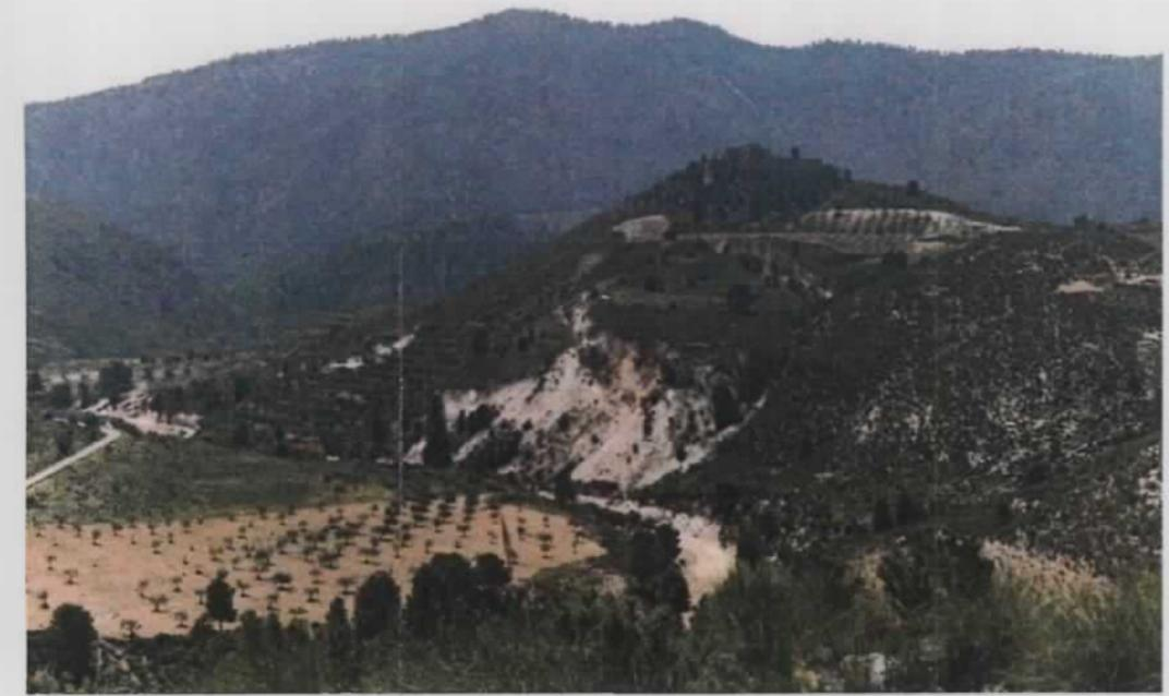
Deslizamiento en la serie miocenas de Híjar. Imagen del año 1989. Este deslizamiento en el año 1993 volvió a desplazar la masa desgajada hasta cegar la rambla.
